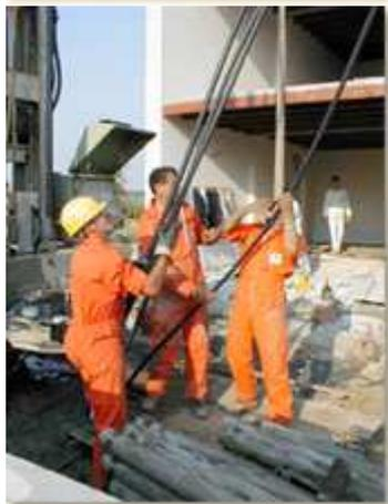
Il numero delle sonde geotermiche e la profondità d'installazione (**da 50 a 150 metri**) variano in funzione dell'energia termica richiesta.
