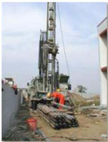
Lo scambio di calore con il terreno avviene tramite la sonda di captazione, installata con una perforazione del diametro di pochi centimetri, in un foro scavato accanto all'edificio, invisibile dopo la costruzione
